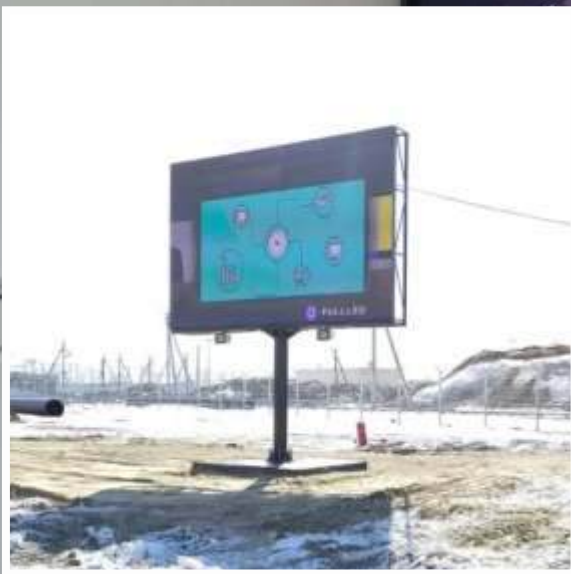
Установка светодиодного экрана на Курской АЭС-2, Курская область, с. Макаровка
